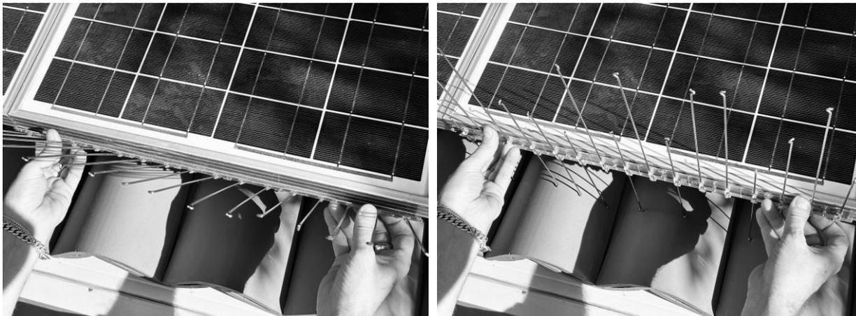
**Nota bene!** I segmenti filiformi inizieranno a scendere autonomamente per effetto gravità scorrendo dentro le proprie sedi di ancoraggio fino ad appoggiarsi alla copertura sottostante in maniera uniforme. Nel caso in cui alcuni segmenti non dovessero scendere autonomamente effettuare una leggera pressione con le mani sulla sommità degli stessi filamenti fino a portarli al raggiungimento del loro fine corsa a ridosso della copertura (vedi esempio sottostante)
